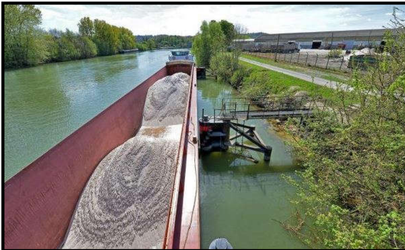
Evacuation des matériaux par péniche
